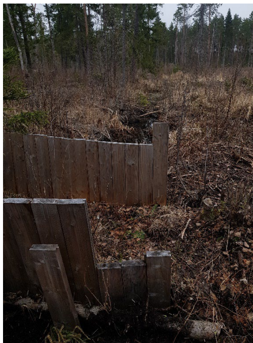
Fig. 1: Pluggning av dike vid Frossarbo.
